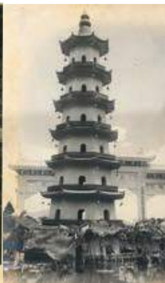
七級浮屠塔 化煞寶塔置於明性堂前方
