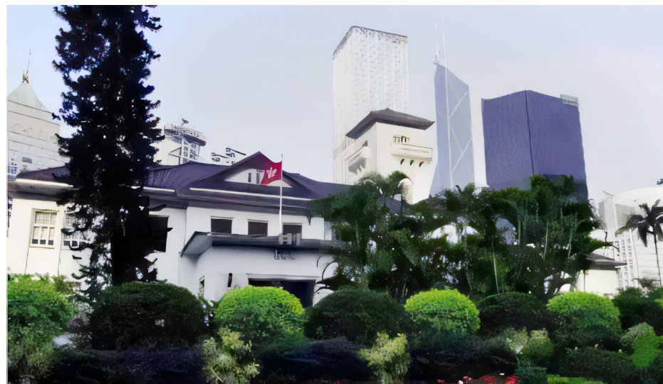
日佔時期（1941—1945）大規模改建，增設獨特日式塔樓； 禮賓府日式塔樓現貌
